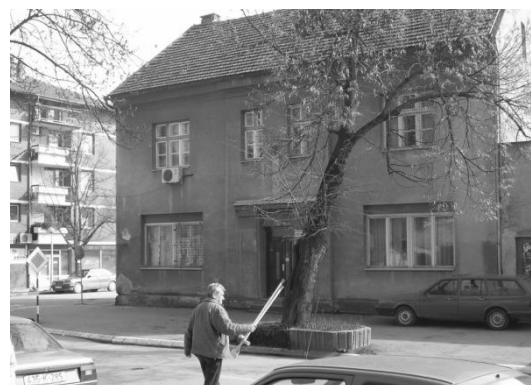
Zgrada u kojoj je bila štamparija "Trinki Moric"
